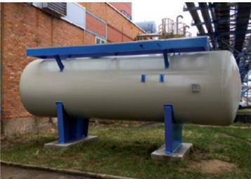
Druck- und Vakuumbehälter
